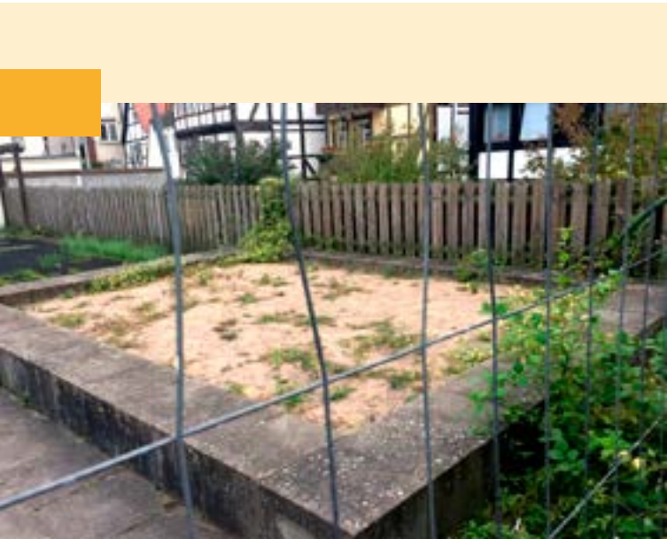
Abbildung 9: Sanierungsbedürftiger Spielplatz in der Hamelner Altstadt. Foto: CIMA.
