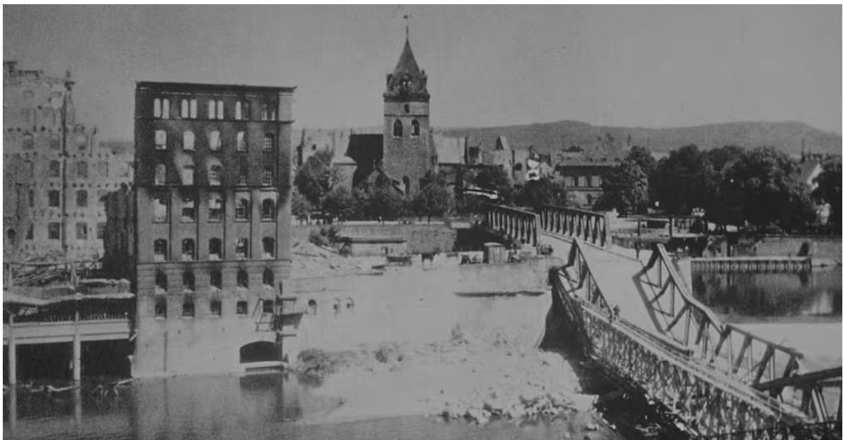
Der zerstörte Weserbrücke / Pfortmühle, Quelle: Stadtarchiv Hameln
