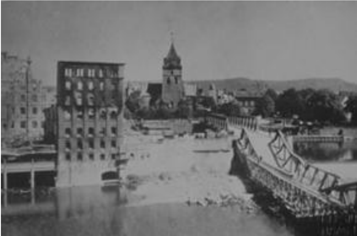
Kriegszerstörungen in Hameln durch den sog. „Nero“-Befehl: links die Mühle auf dem Werder, rechts die Weserbrücke.
