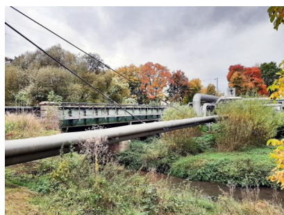
Die Eisenbahnüberführung „Fluthamel“ hat das Ende ihrer Nutzungsdauer nahezu erreicht und wird durch einen Neubau ersetzt (März 2020) [Quelle: DB Netz AG]
